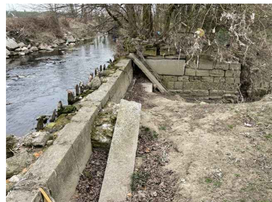
Gavvata da ripristinare e rimozione accumuli in alvee con riutilizzo in loco per ture e pise di cantiere
